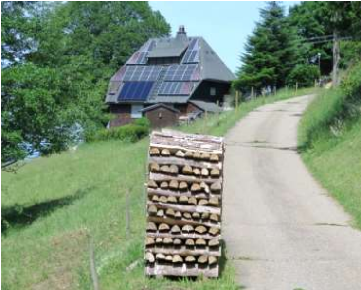
Abb. 23: Fotovoltaik und Solaranlage am Berglusthaus (25.5.2017)
