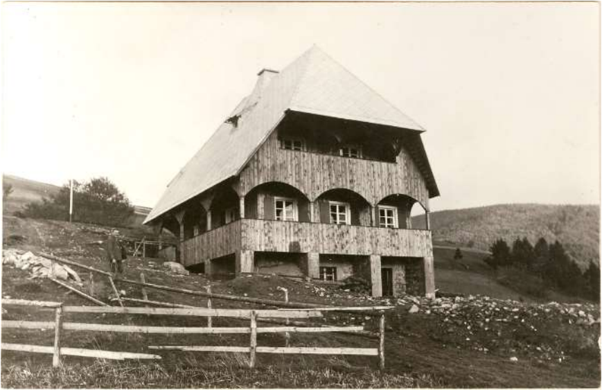
Abb. 8: Das Berglusthaus 1926 nach Anbringung der Holzverschalung
