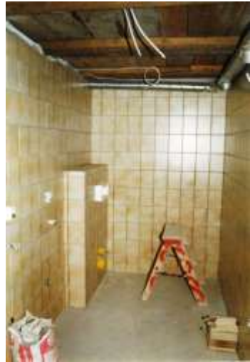
Abb. 20b: Bau des neuen Waschrums 1987
