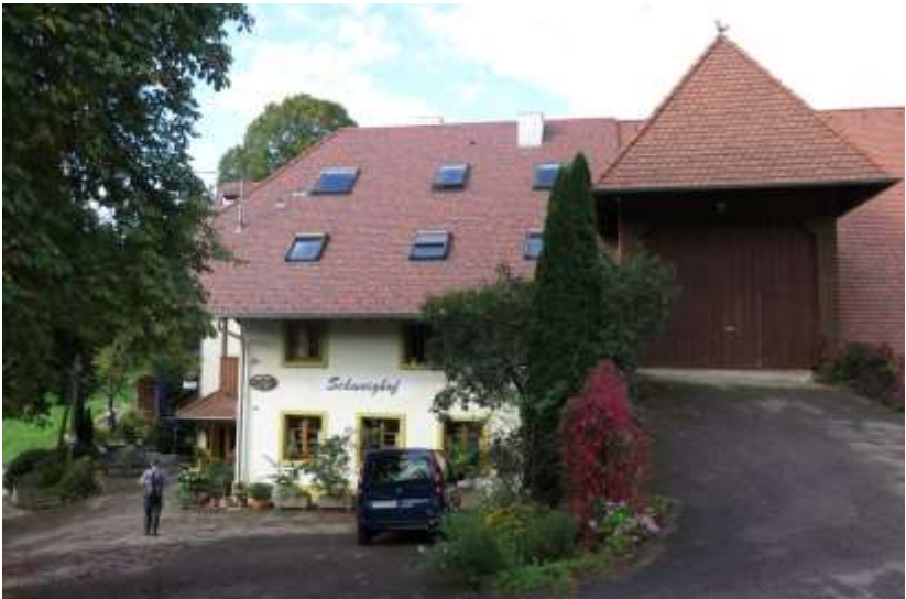
Abb. 40: Der Schweighof mit bergseitiger Dacheinfahrt
