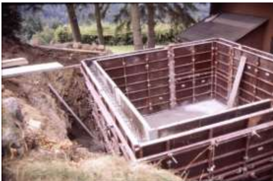
Abb. 19: Erstellung des Weinkellers 1986
