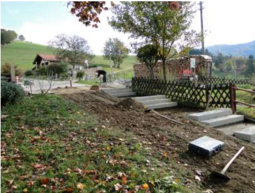
Abb. 26: Bau der neuen Treppe zum Berglusthaus (15.10.2009)
