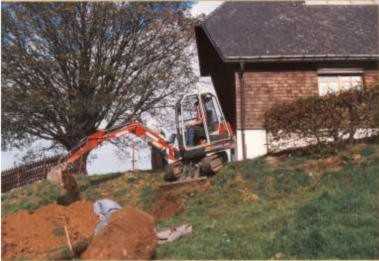
Abb. 22: Anschluß an die Abwasserleitung 1995
