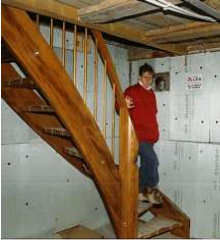
Abb. 20a: Kellerisolierung und Einbau der Kellertreppe
